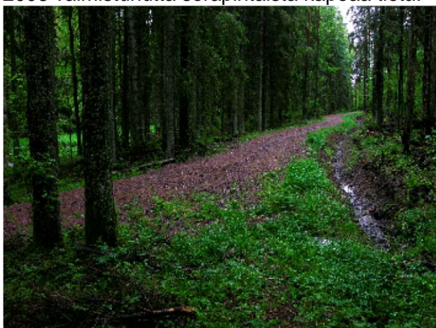
Tervaskannon alueen soratie kuvattuna sillan kohdalta etelään.
